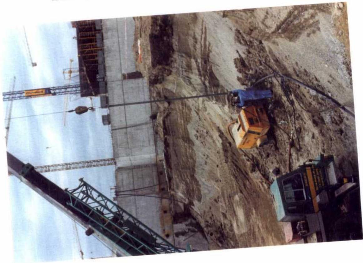
FIGURA 7.17. COLOCACION DE UNA BOMBA EN UN POZO
